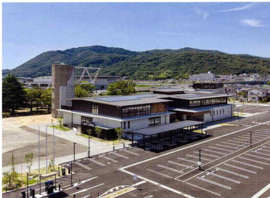
全景（敷地北東側から）
