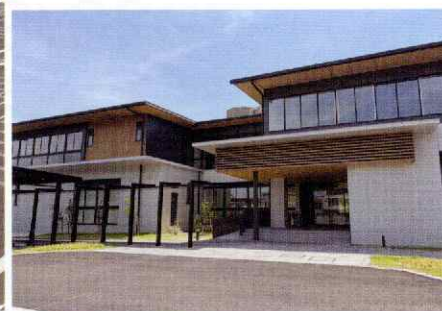
1Fメインエントランス（北側）
